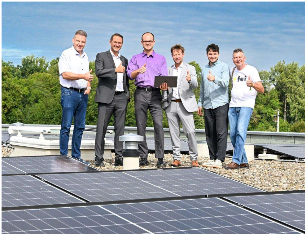
Solarstrom fürs Ärztehaus: v.l. Dr. Wolfgang Steinbach (Arzt), Thomas Neumer (GEWOBAU-Bamberg eG), Joshua Kurz (fei Bürgerenergie eG), Dieter Welscher (GEWOBAU-Bamberg eG), Gabriel Schumm und Gregor Christa (beide fei Bürgerenergie eG) begutachten die neue Photovoltaikanlage auf dem Dach des Ärztehauses in Scheßlitz. Die 64 kWp-Anlage versorgt das Gebäude seit Juli 2026 anteilig mit vor Ort erzeugtem Solarstrom. Foto: GEWOBAU-Bamberg eG. Abdruck im Zusammenhang mit dieser Meldung frei.
